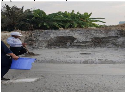
Hình 1. Thu gom BTBT tại trạm trộn bê tông
