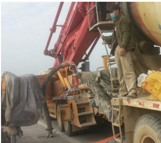
Hình 1 – Hình ảnh bơm bê tông đông cứng nhanh [1]
